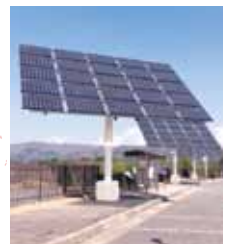
▲太陽の光を追う 「追尾式太陽光発電システム」
